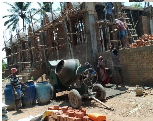
Bau der Pfeiler 2022
