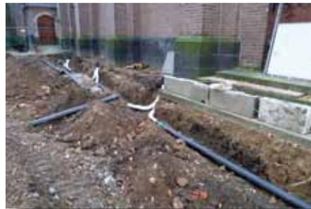
Demgemäß werden im Zuge der Platzsanierung jetzt auch alle Abwasserrohre unter dem Platz erneuert. Dies erklärt die zahlreichen Erdgräben, die zum Auftakt der Erdarbeiten ausgehoben werden mussten.
